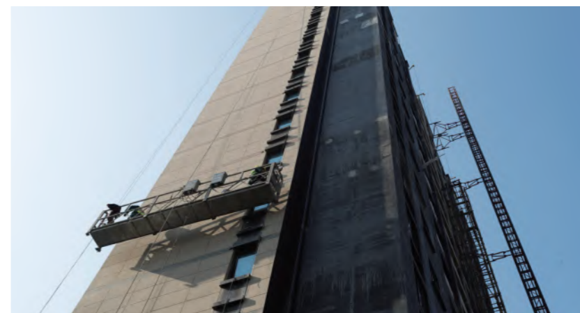
» 上海奉贤区在建涂料工程
