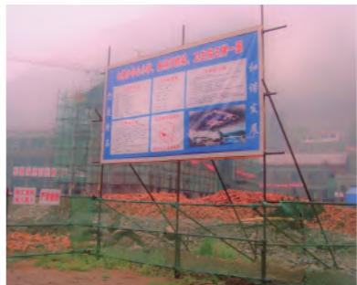
» 援川建设工地
