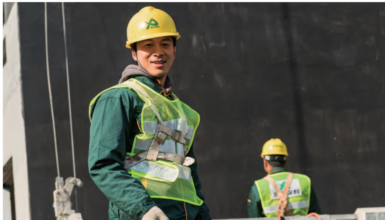
工地上，悉奥施工人员全副武装开展涂装工作
